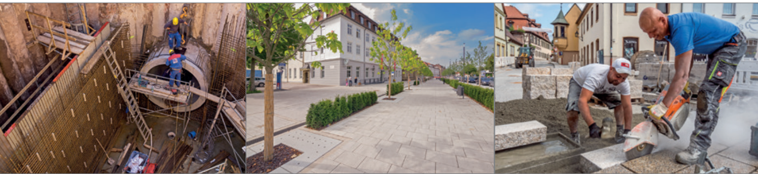
Die Promenade in Ansbach: unser bisher größtes Projekt im Bereich Tiefbau. Baubeginn 2011, Fertigstellung 2018.
