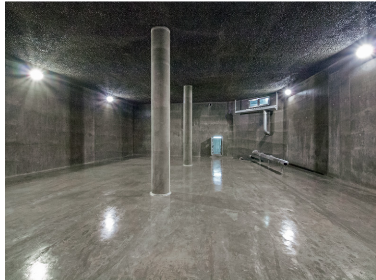
↓ Wasserspeicher Weißenburg – Neubau Ver- und Entsorgung
