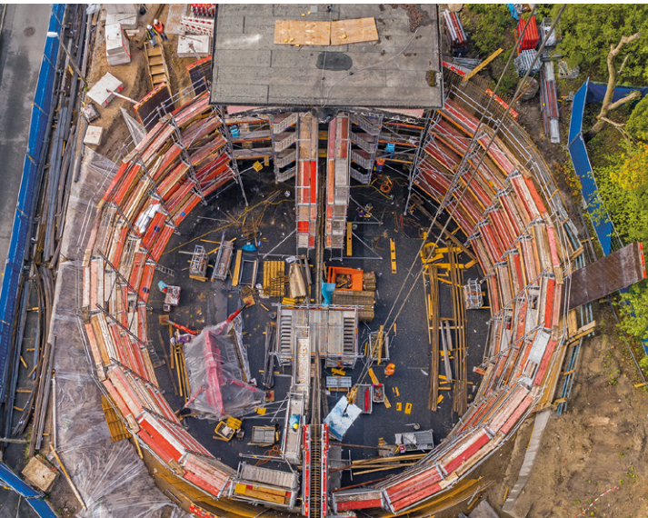
↓ Ersatzneubau Wasserspeicher Erlangen
