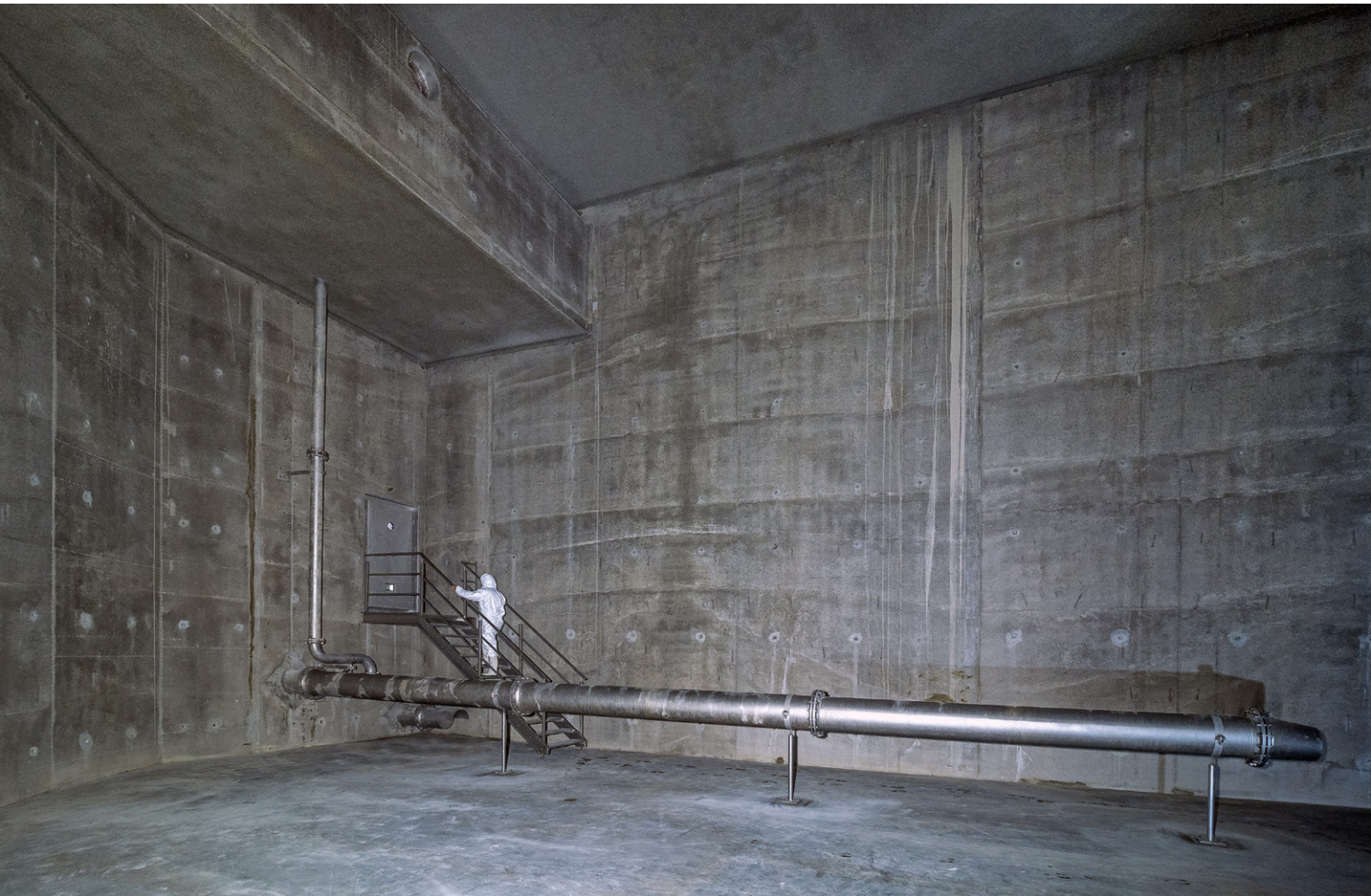
↓ Ersatzneubau Wasserspeicher Erlangen
