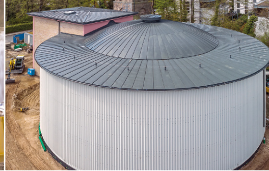
↑ Ersatzneubau Wasserspeicher Erlangen
